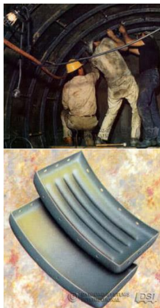
Applicazione di liner plates (DSI).
