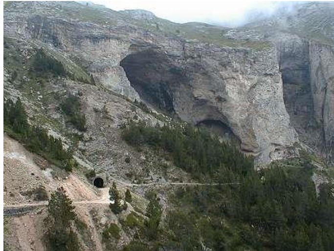
Imbocco di monte.
